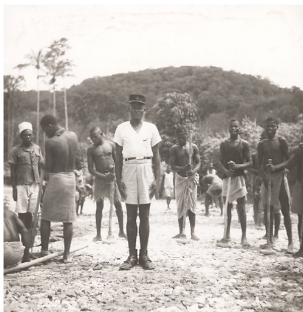
Travailleur sur la route de Mouila-Onoï, Gabon
