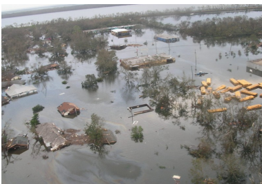
Après le passage d'un cyclone
