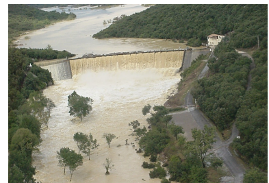
Rupture d'un barrage
