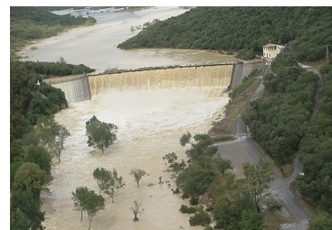
Rupture d'un barrage
