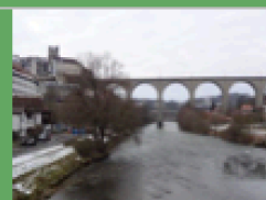
Pont de Bern
